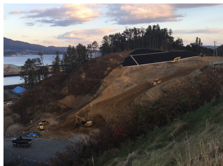
陸前高田の造成工事
